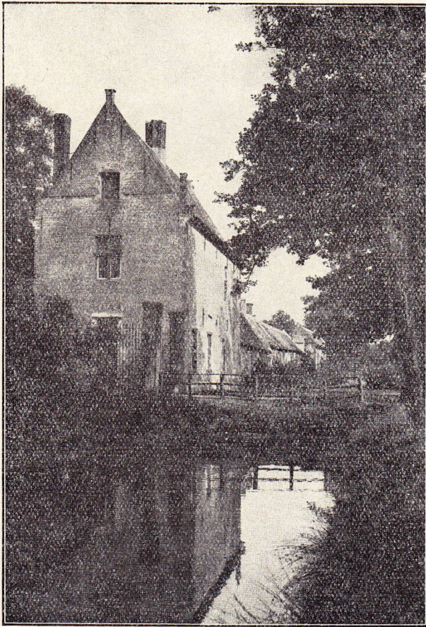
Vieux-Turnhout. — Les murs extérieurs de l'ancienne abbaye de Corsendonck.
